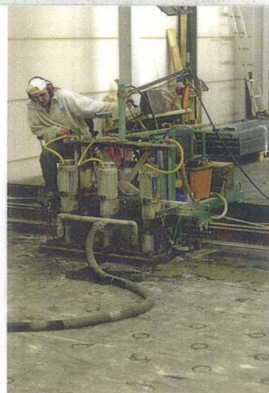
De bemande diamantboormachine boort drie gaten tegelijk
